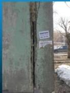
Особое внимание уделяется теплоизоляции выступающих угловых вертикальных стыков наружных стен, где теплопотери максимальны.
